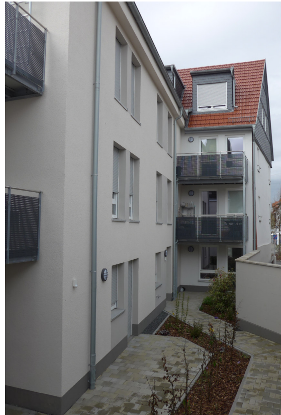
Hofansicht mit Anbau
