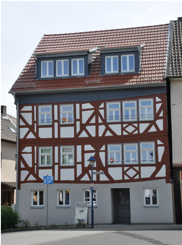
Strassenansicht nach Sanierung
