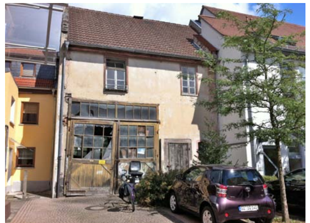
Hoffassade vor dem Umbau
