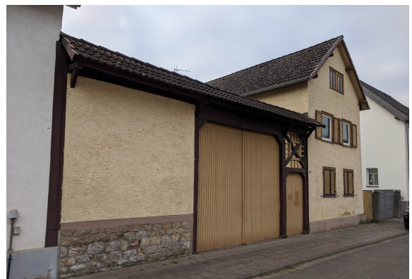
Strassenansicht vor Umbau
