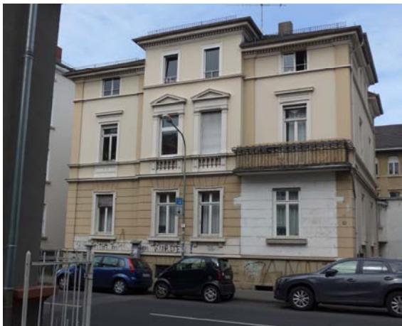
Vorderhaus vor der Sanierung
