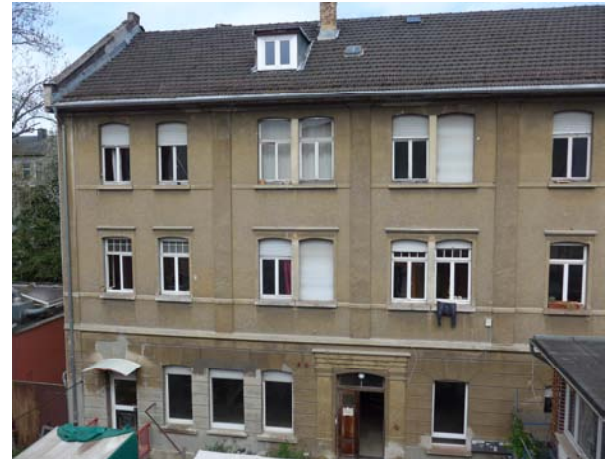
Hofansicht Hinterhaus vor der Sanierung
