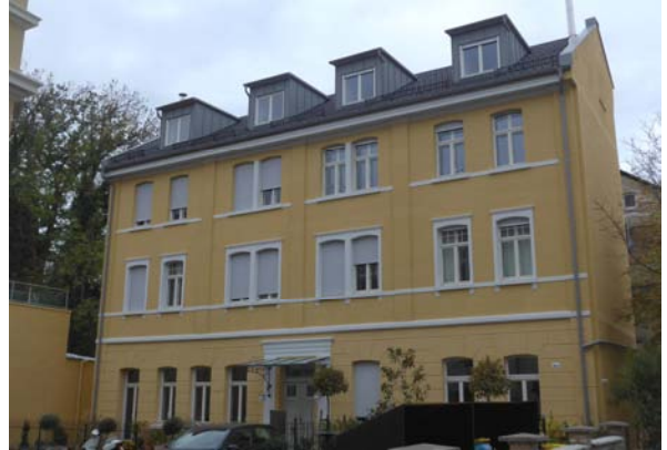
Hoffassade Hinterhaus nach Sanierung
